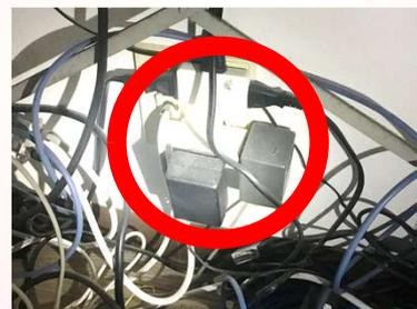
電気差し込みでたこ足配線になって、プラグコンセントに埃が付着している
