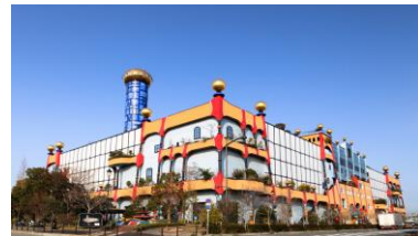
汚泥溶融設備
